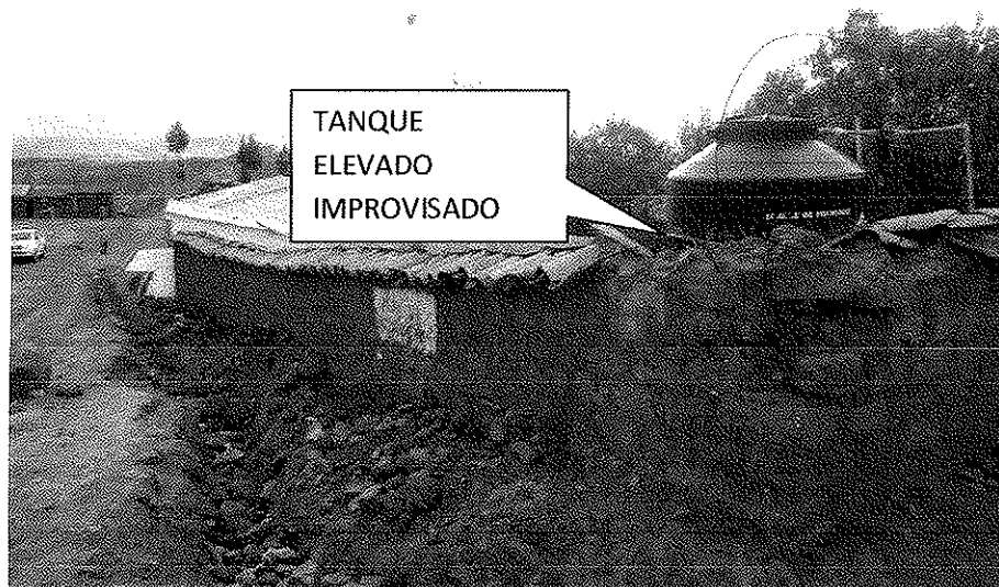
Foto 08.- Tanque elevado instalado de manera provisoria.
