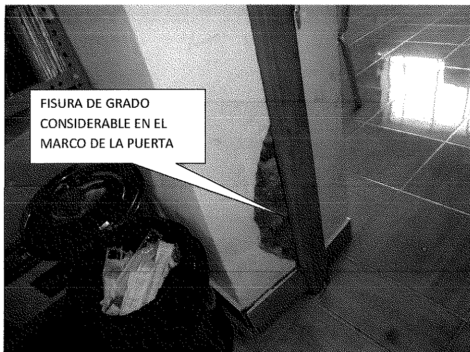
Foto 06.- Fisura y rotura del revestimiento de yeso en algunas puerta del EE.SS.
