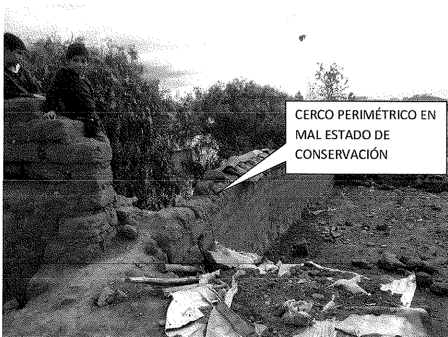
Foto 09.- cerco perimétrico con riesgo de colapsar.
