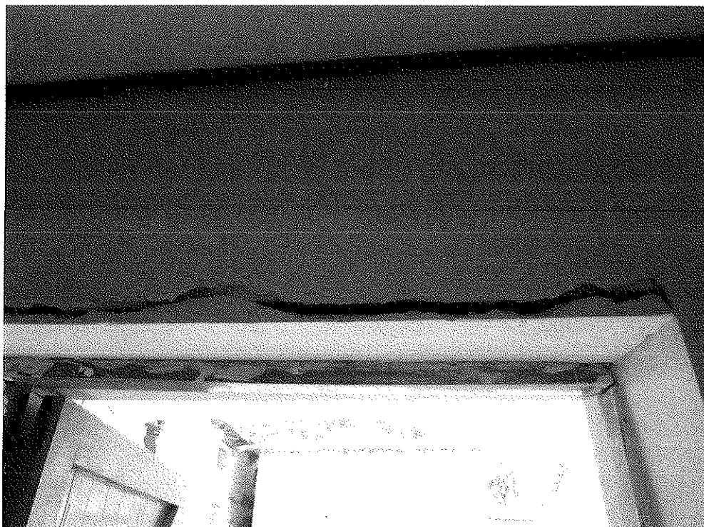
Foto 02.- fisura en el umbral de puerta del EE.SS. "Urpay"
